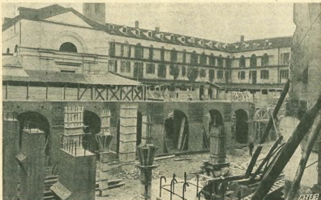
Torino - Una parte delle fondamenta dell'ampliamento della basilica di Maria Ausiliatrice.
